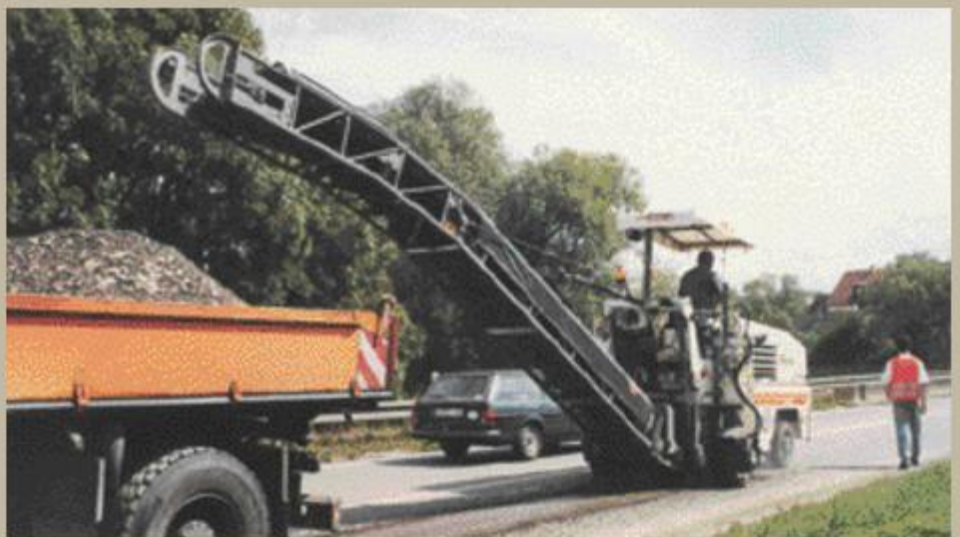
A nyomvályú megszüntetése marással
