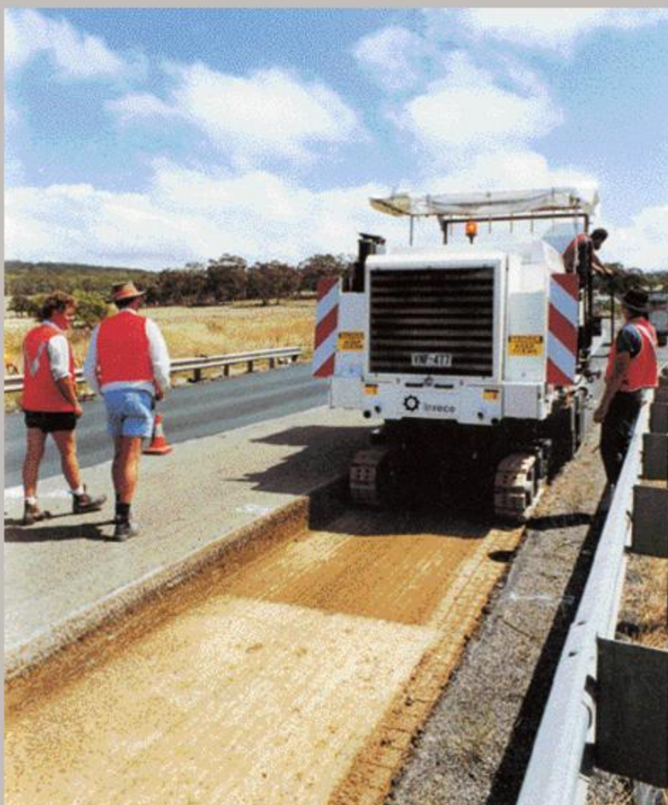
W 2000 nagy teljesítményű marógép munkában
