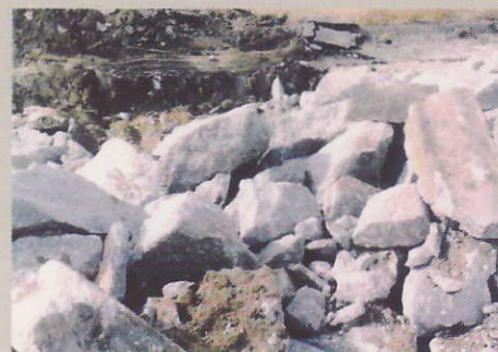
Aszfalt és betonpálya szerkezet törés, bontás
