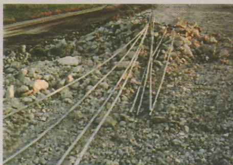
Vasbeton burkolatok szétválasztó bontása
