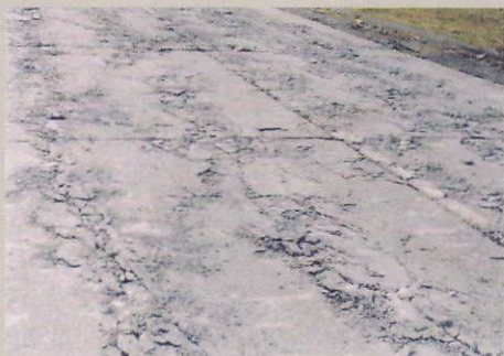
Beton pályaszerkezetek „crack and seat” leültető repesztése
