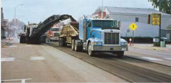
Kopóréteg marás 3,8m szélességben
