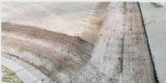
Aszfalt csatlakozás marása
