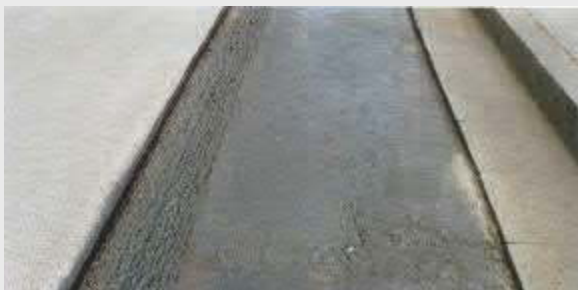
Aszfalt csatlakozás marása
