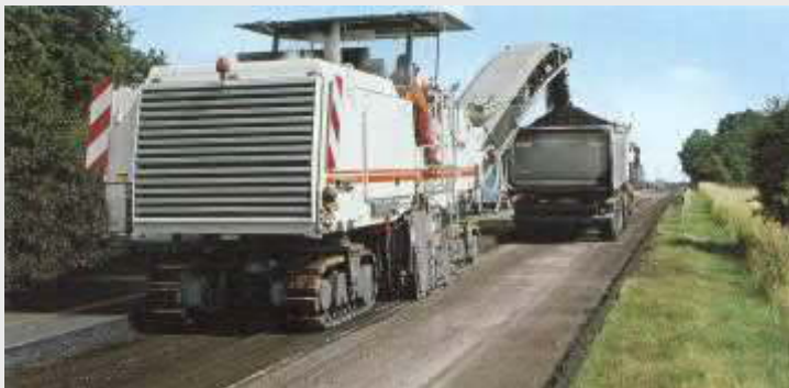
Aszfalt rétegek marása
